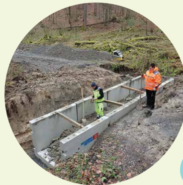
Einbau Rahmenprofil
