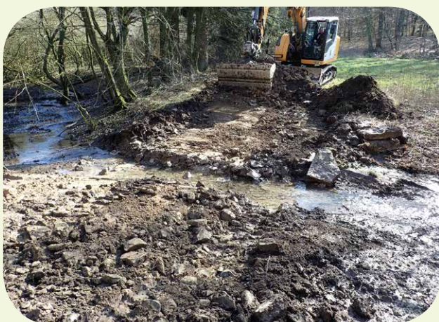
Bau einer unbefestigten Weidefurt
